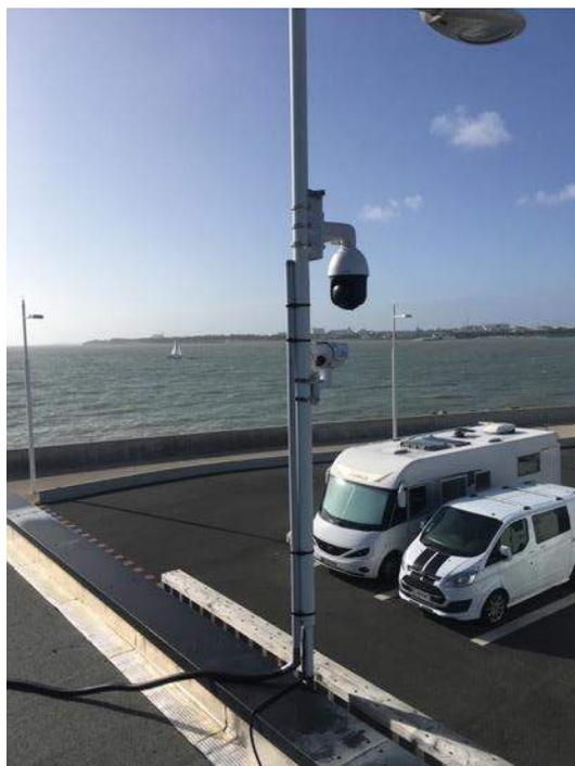
Photo 19 : Arrivée des câbles des webcams (en haut à droite de l'image) et boîte regroupant les branchements (auteur : Valentin Guyonnard, le 24 septembre 2019)
